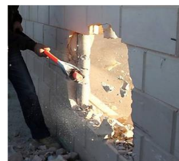
Rompiendo el muro
