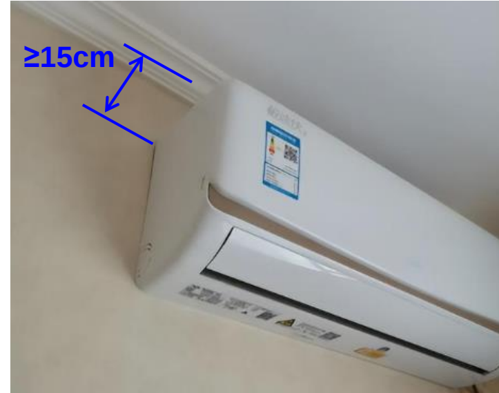
Instalación Correcta
