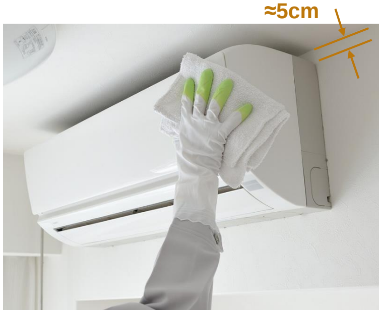
Instalación Incorrecta
